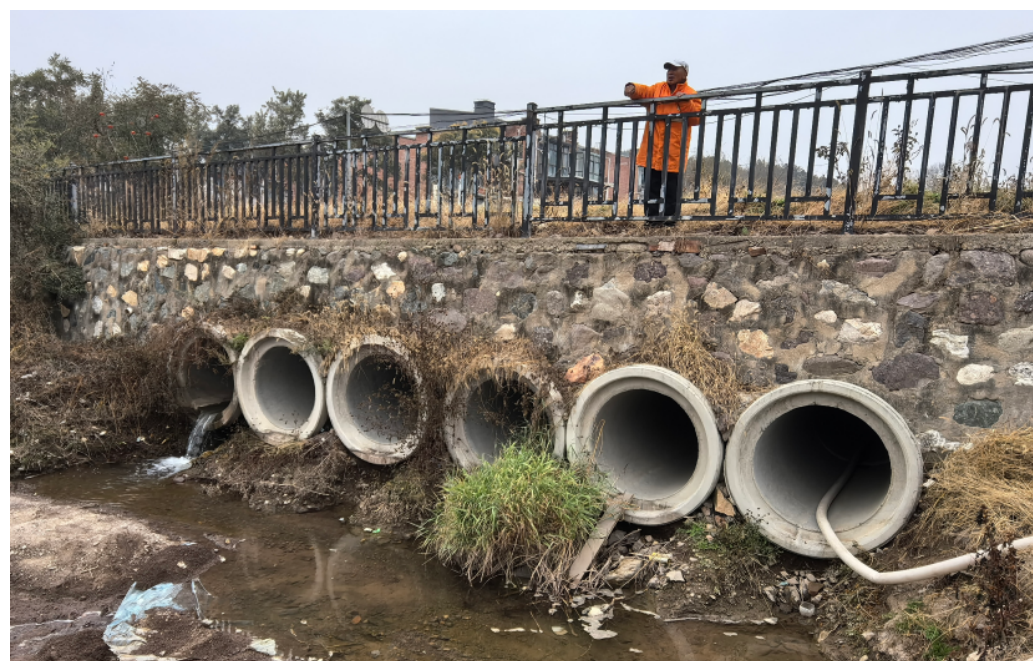
桥梁下游混凝土管
